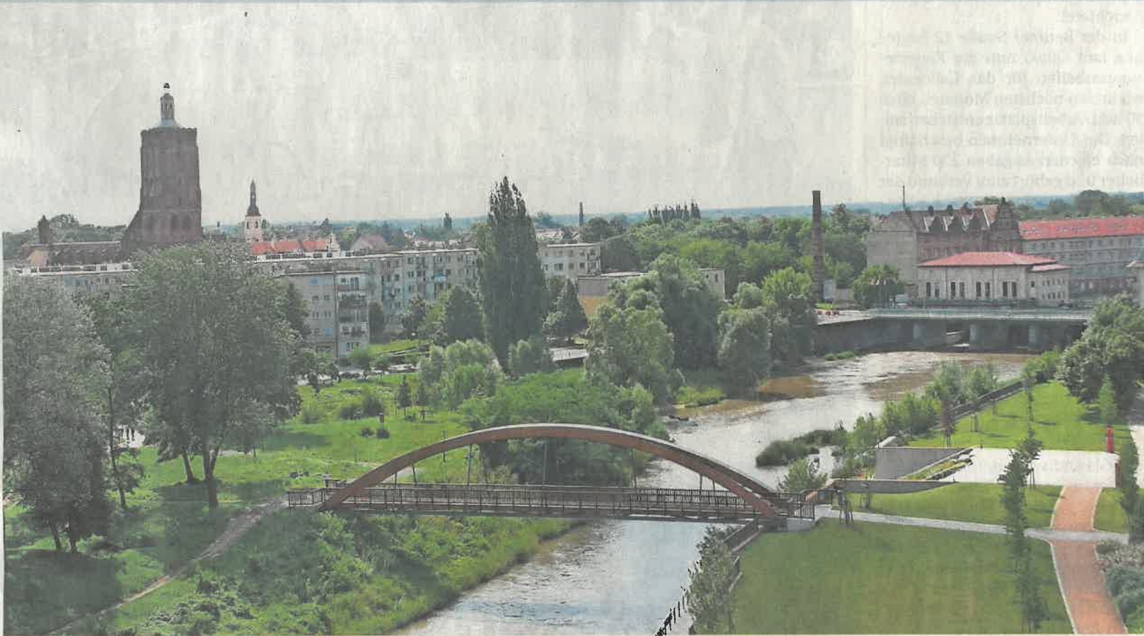
Durch Projekte der Euroregion Spree-Neiße Bober gibt es heute zahlreiche Brücken zwischen Deutschland und Polen.
